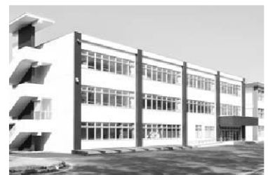
⑩ 恵明中学校増築事業 恵明中学校の増築工事を行いました
