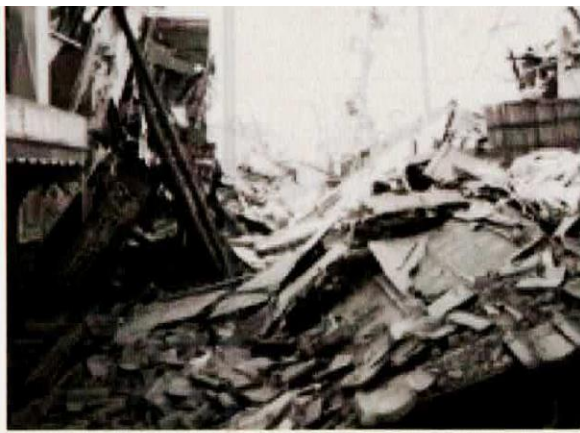
阪神・淡路大震災1カ月後の神戸市・長田区を撮影したもの。 家屋が傾き、倒壊した家屋が道路をふさいでいる。
