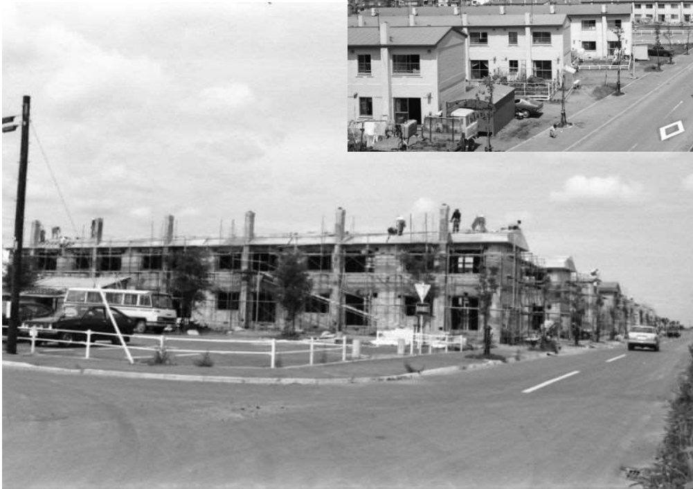
1976.9 柏陽団地建設中の様子
