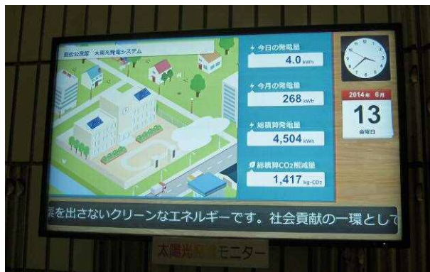
島松公民館に設置された太陽光発電設備(5.5kw)と発電電力量のモニター（館内に設置）
