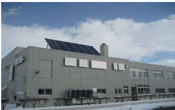
島松公民館に設置された太陽光発電設備(5.5kw)と発電電力量のモニター（館内に設置）
