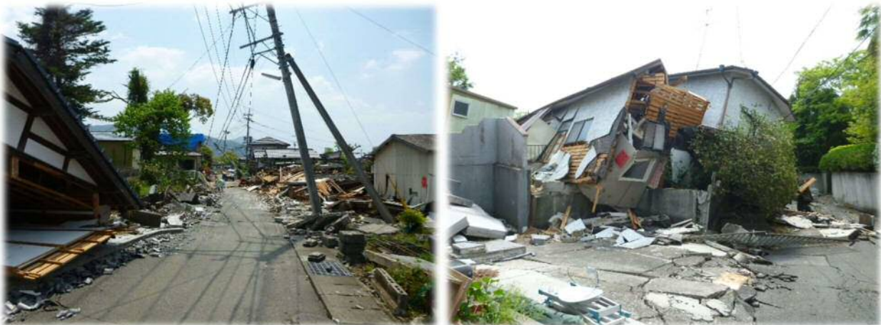
■ 図 1-3 平成 28 年熊本地震直後の状況写真(熊本県益城町)
