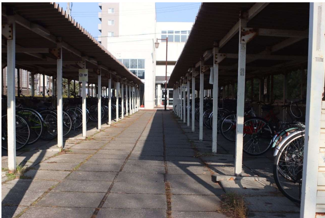
恵み野駅西口駐輪場（屋根あり）
