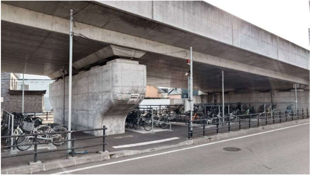
恵庭駅西口高架下駐輪場Cブロック
