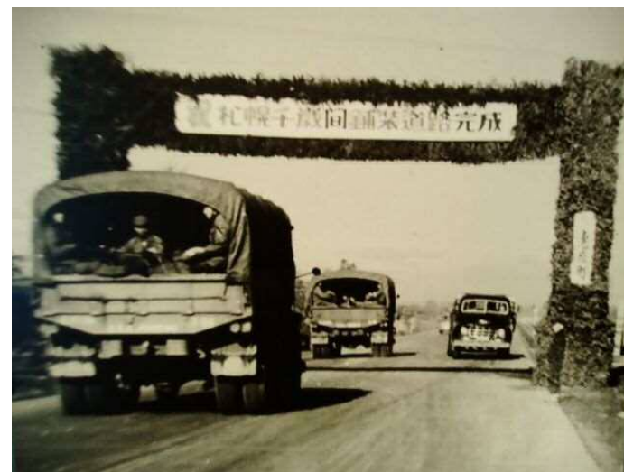
国道36号線開通舗装道路完成(昭和28年)
