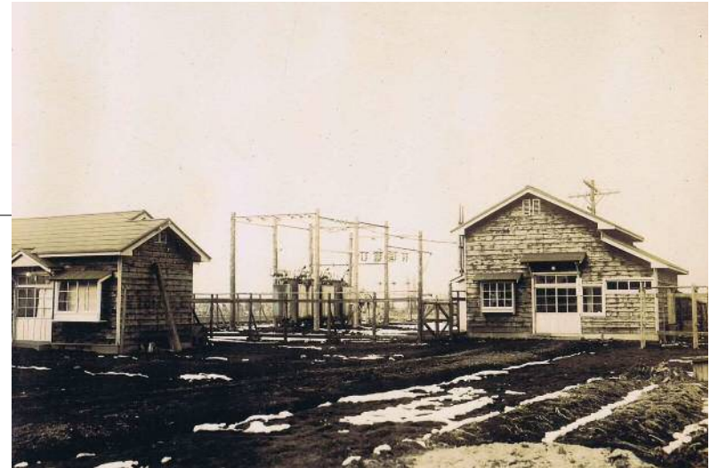
島松駅変電所
