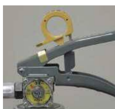
× 安全栓の抜けかけ
