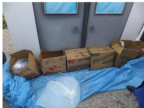
ダンボール等を使用した浸水対策
