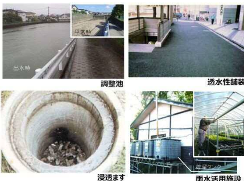
雨水貯留浸透施設の例
