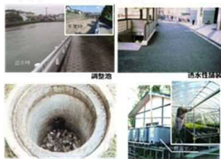
雨水貯留浸透施設の例
