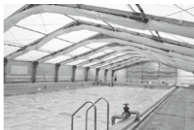
島松水泳プール
