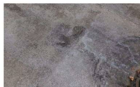
屋上防水状況
