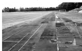
恵庭公園陸上グラウンドの現状
