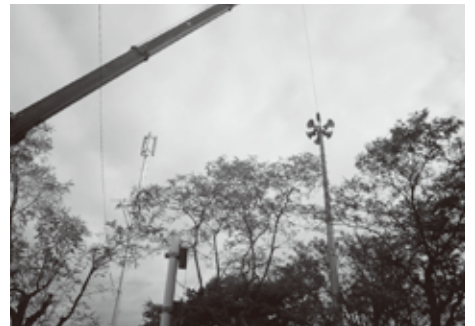
更新作業中の防災行政無線機器
