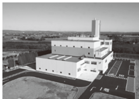
恵庭市焼却施設の全景
