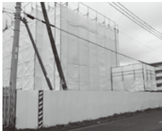
建設中の恵央団地6号棟
