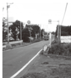
南18号線に設置されている注意喚起の看板
