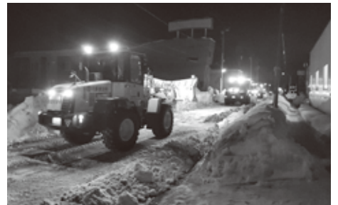
夜間に稼働する除雪ドーザー
