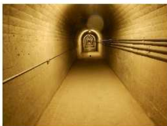
右岸グラウトトンネル状況写真 断面：幅2.0m、高さ2.4m 延長：約200m
