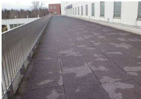
2階 屋上テラス
