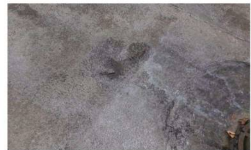
屋上防水状況
