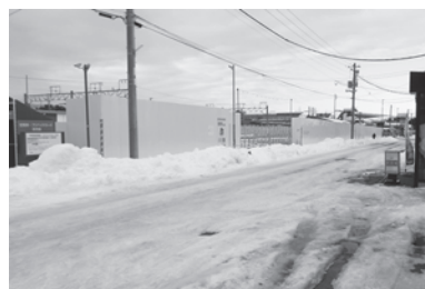
島松複合施設建設現場
