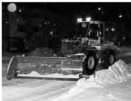
稼働する除雪ドーザー
