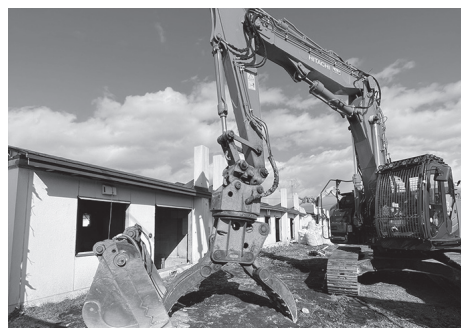
解体が始められた市営住宅柏陽団地
