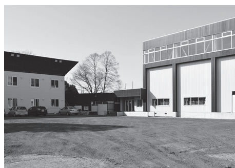
解体された旧駒場体育館
