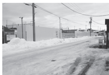
島松複合施設建設現場
