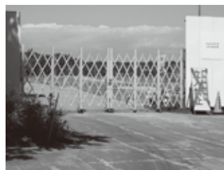
ラピダス社工場建設予定地(千歳市)
