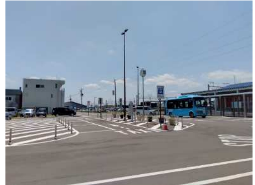
〈図1 島松駅東口駅前広場整備後状況〉
