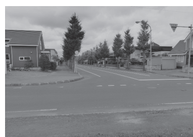
信号機移設場所（団地中央通丁字路交差点）
