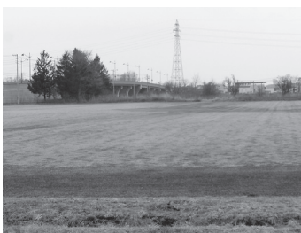
戸磯南工業団地
