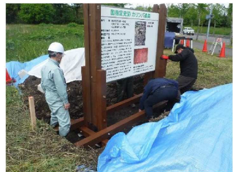
史跡カリンバ遺跡説明板再建工事
