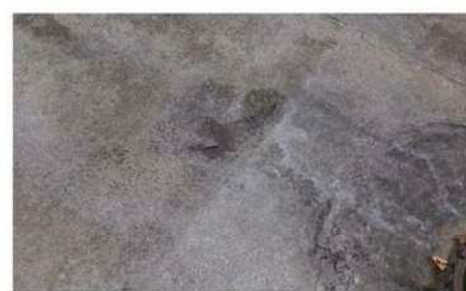
屋上防水状況
