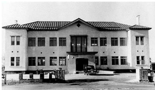
た やくば 新しく建てられた町役場（昭和 27 年）
