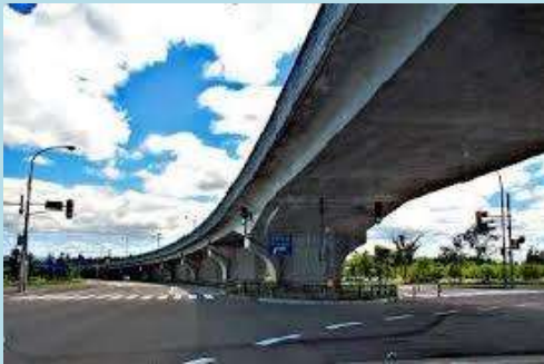
恵み野跨線橋
