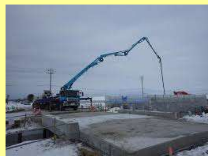
北島松のはい水路
