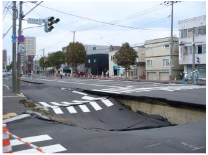
イ 地震によって陥没した道路（札幌市）
