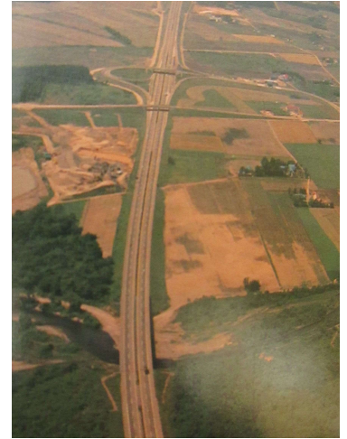
力 かいつう 開通したところの高速道路
