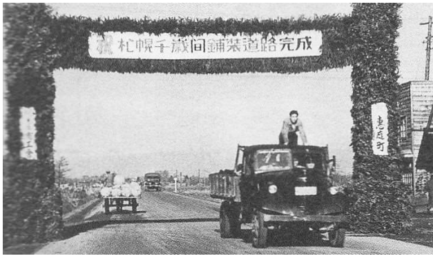
才 ほそうになった国道 36 号 1953 (昭和 28) 年
