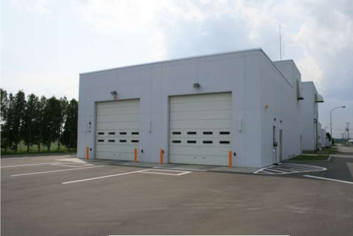
ア 生ごみ・し尿処理場
