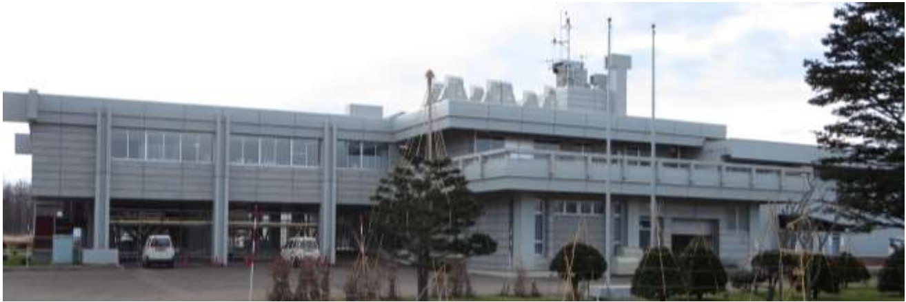
ア 漁川浄水場
