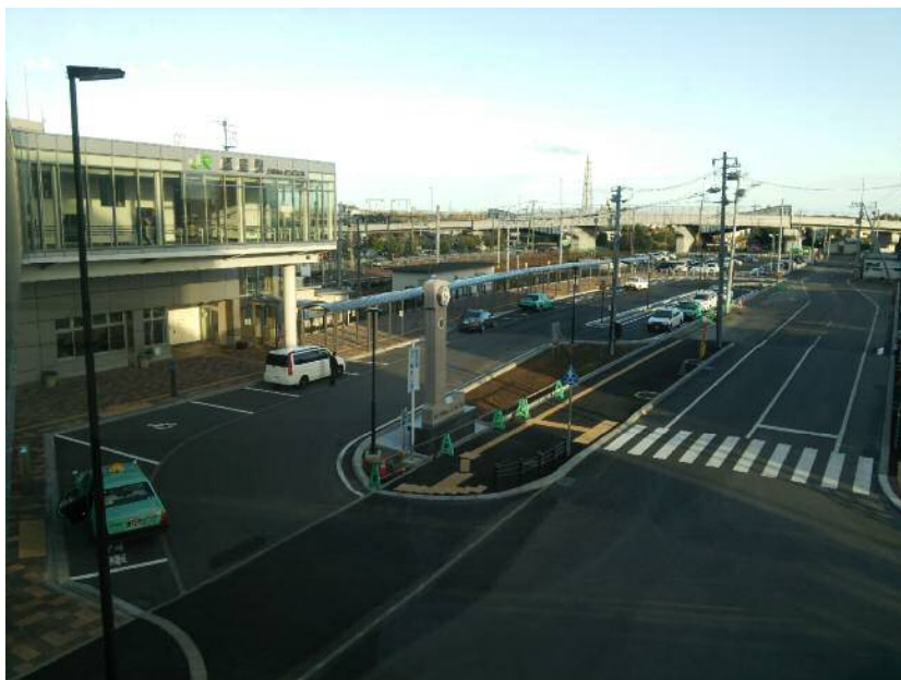
整備後の恵庭駅西口駅前広場（H27.10 撮影）
