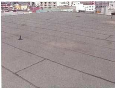
●アスファルト系防水の例*1
