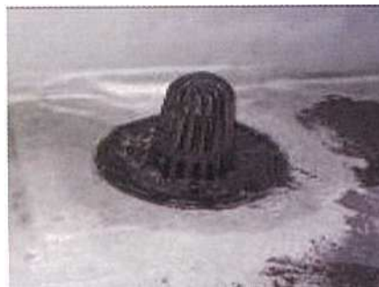
●固定金具による凸部の例*1
