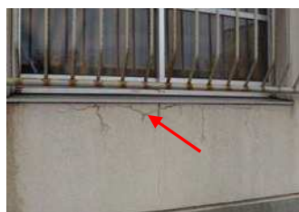
●開口部（周辺）のひび割れ等 （左：開口部（入隅部）のひび割れ、右：サッシ廻りのひび割れ）
