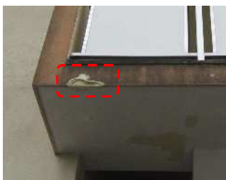
●バルコニー先端部の欠損 （左：モルタルの剥落、右：コンクリートの欠損）
