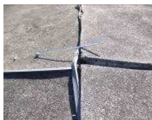
●押えコンクリートの目地のせり上がり*2
