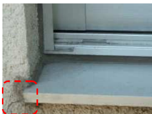
●開口部（周辺）のひび割れ等 （左：開口部（入隅部）のひび割れ、右：サッシ廻りのひび割れ）
