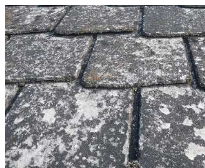
●化粧スレート表面の塗り仕上げのはく離
