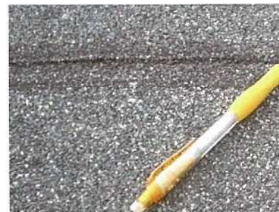
●アスファルト系防水表面の砂粒の例*1
