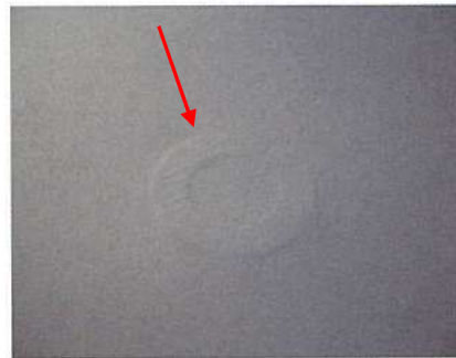
●固定金具による凸部の例*1
