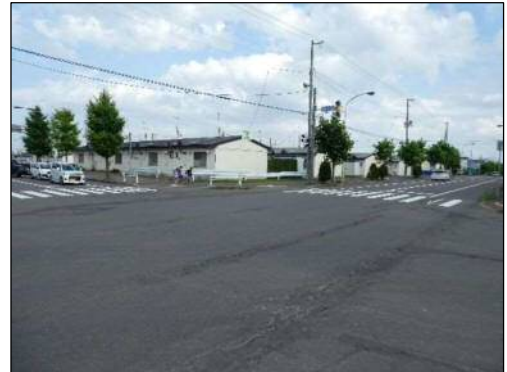
柏陽団地南側敷地の平屋建住棟
