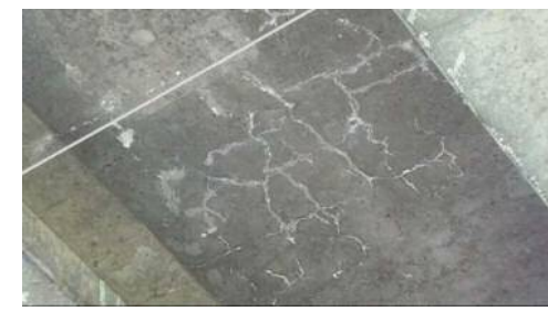
付写真2.8 第5径間RC床版下面
