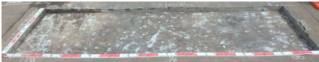
付写真6.2 No.7-1 第7径間-1 舗装切削後の主桁上面の状況
