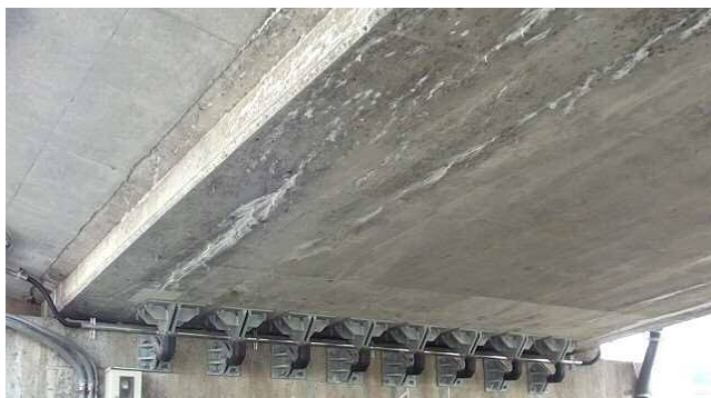
3径間連続PC中空床版 (起点方 (第1径間) )
