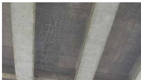
付写真2.5 第4径間RC床版下面
