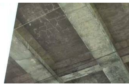
付写真2.7 第5径間RC床版下面
