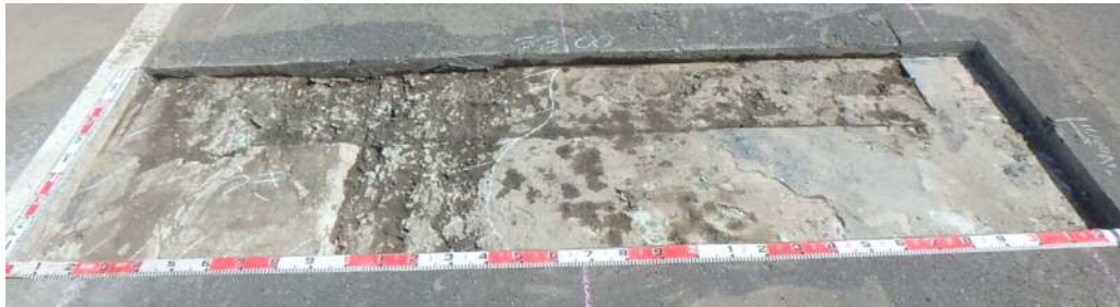
付写真6.1 No.1-2 第1径間-2 舗装切削後の主桁上面の状況
