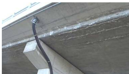
付写真2.2 中間支点（第1-2径間）
