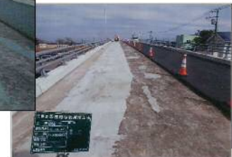
【断面修復後の主桁上面状況】
