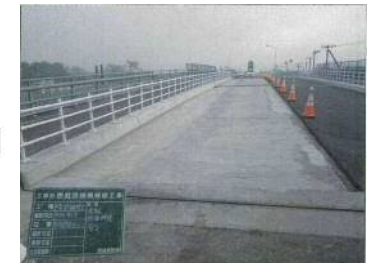
付図1.1 平成28年度 PC中空床版桁 張出し床版の状況（左図：1～3径間，右図：6～11径間）
