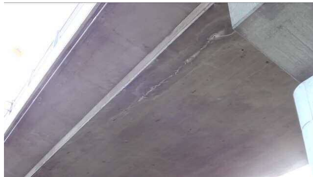
3径間連続PC中空床版 (終点方 (第6径間) )
