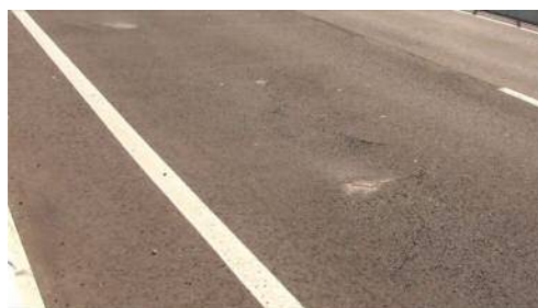
付写真2.6 第4径間RC床版上面の舗装
