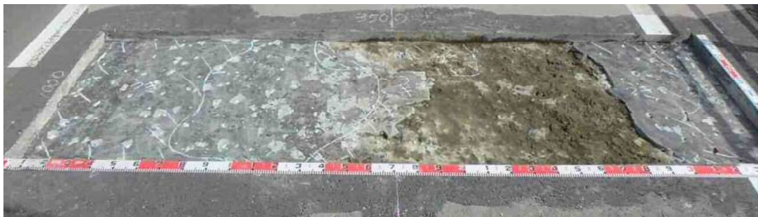
付写真6.4 No.4-2 第4径間-2 (R側) 舗装切削後の床版上面の状況
