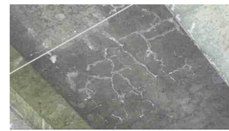
付写真2.8 第5径間RC床版下面
