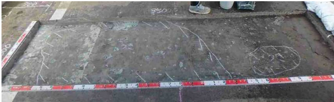
付写真6.3 No.4-1 第4径間-1 (L側) 舗装切削後の床版上面の状況
