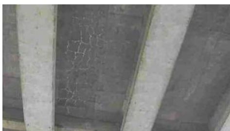
付写真2.5 第4径間RC床版下面
