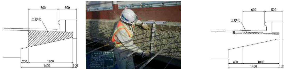
付図1.1 平成28年度 PC中空床版桁 張出し床版の状況（左図：1～3径間、右図：6～11径間）
