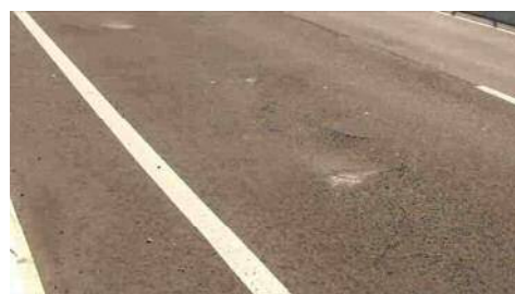
付写真2.6 第4径間RC床版上面の舗装
