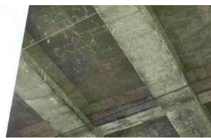
付写真2.7 第5径間RC床版下面
