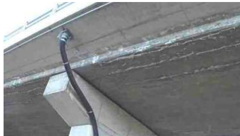
付写真2.2 中間支点（第1-2径間）
