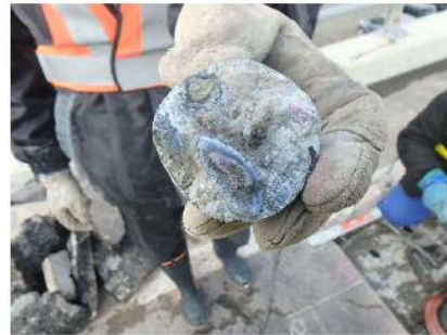
写真 3-19 ひび割れ面の状況
