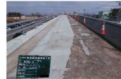
写真 5-2 H30 断面修復後の状況
