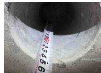
写真 3-26 健全部の削孔内状況
