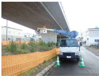
写真 3-25 高所作業車による調査状況
