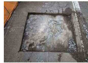
写真③ 舗装切削後状況
