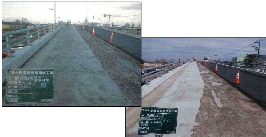
【断面修復後の主桁上面状況】
