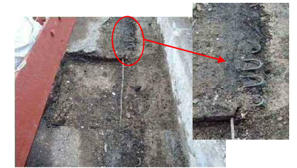
写真② ロードヒーティング状況
