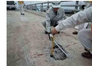
【ボイド管貫通状況】
