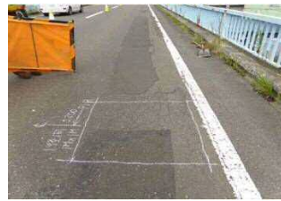
写真② 舗装切削箇所
