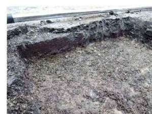
写真① R側路肩部の主桁上面状況
