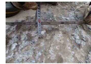
写真④ 最大深さ主桁上面から80mm
