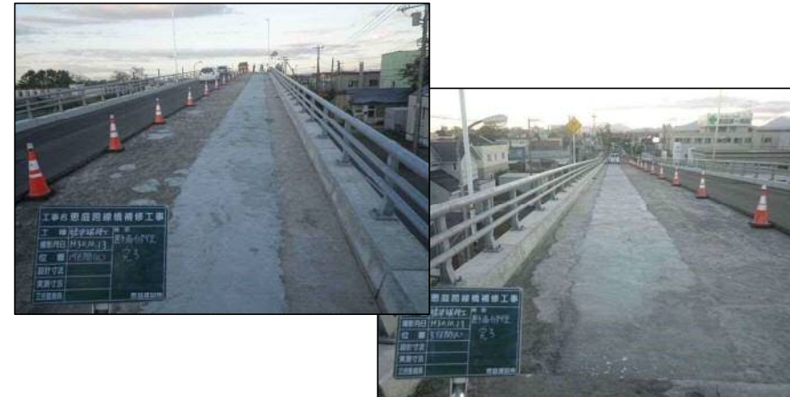
【断面修復後の主桁上面状況】
