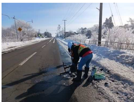
図 1-3 補修作業の様子（例）
