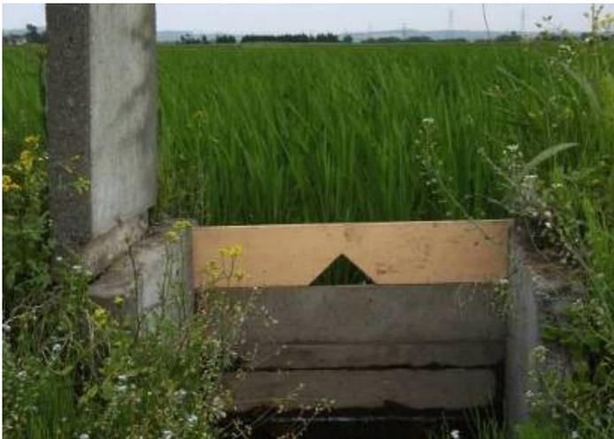
「田んぼダム」～排水口に貯留板を設置し大雨時に板の高さまで水を一時的に貯め、川にすぐ流れ込まないようにする(洪水被害防止)
