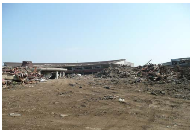
津波の被害があった大川小学校
