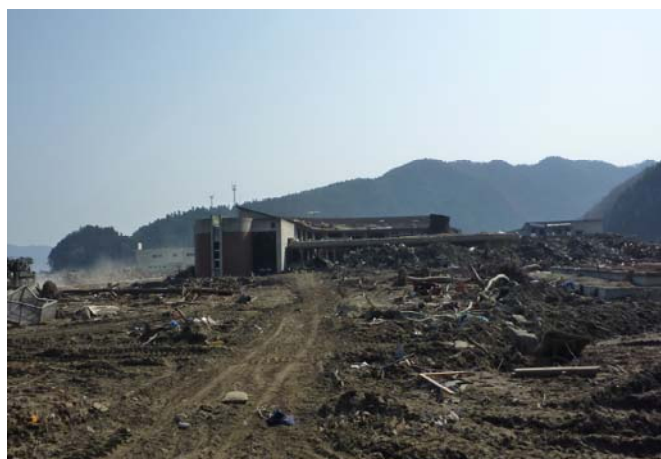
津波の被害があった大川小学校
