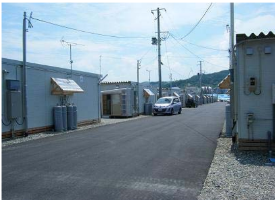
240戸入った市内で一番大きい仮設住宅（郊外にあり交通の便が悪く、スーパーなども遠い）
