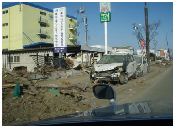
7 岩沼市内津波被害状況
