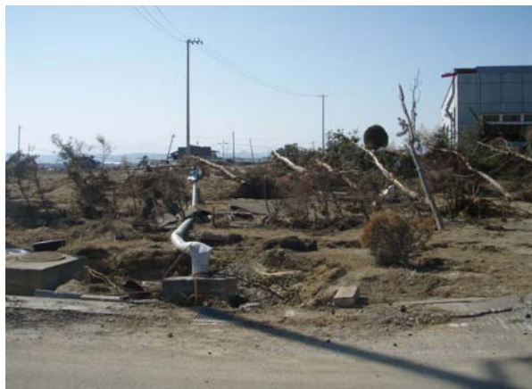
8 岩沼市内津波被害状況
