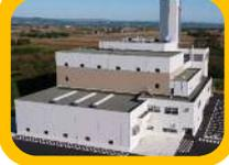
市内で発生した燃やせるごみ、粗大ごみの他、事業系一般廃棄物、産業廃棄物などを焼却処理しています。焼却処理に伴い発生する熱はボイラで回収し、施設内の暖房等に利用する他、隣接施設で利用しています。
