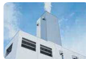
煙突 有害物質が除去された排ガスは、煙突から大気中へ排出されます。
