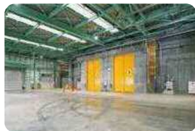
プラットフォーム ごみ収集車等で集められた可燃ごみを安全に、ごみピットへ投入する場所です。
