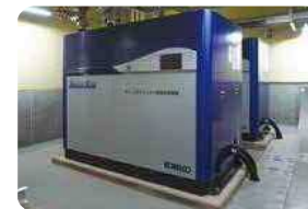
発電機 蒸気を利用して発電を行います。発電した電気は施設内で利用されます。
