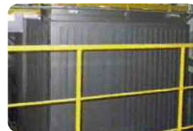
ろ過式集じん器 ろ布(袋状のフィルター)を排ガスが通過することで、排ガス中の有害物質を除去します。
