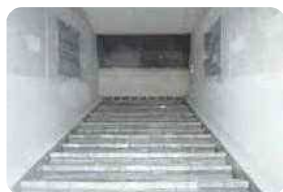
燃焼装置 焼却後の灰は水で満たされた灰搬出装置で消火・冷却され、灰搬出室から場外へ搬出します。
