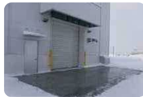
ロードヒーティング 蒸気で作られた温水で、プラットフォーム入口の融雪を行います。
