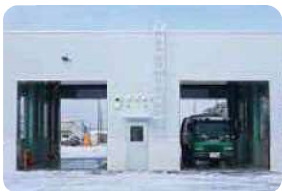
ごみ計量機 施設に搬入される可燃ごみや、生ごみ等の量を計量し、記録します。
