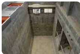
ごみピット ごみピットには約490トンの可燃ごみを貯めておくことができます。
