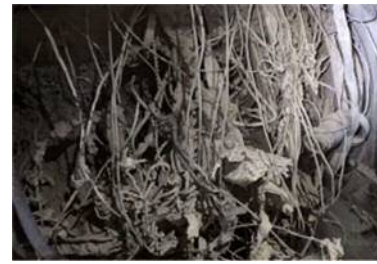
焼却炉に金属類が堆積し、運転停止
