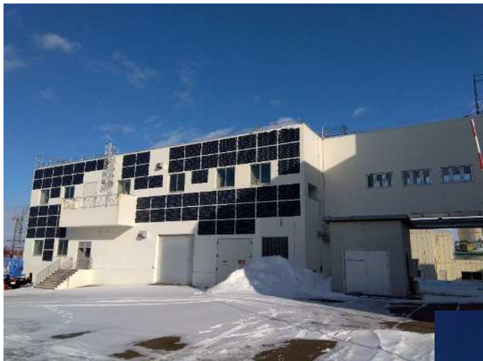
【沈砂ポンプ棟】
