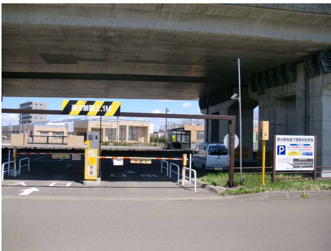
恵み野跨線橋高架下西駐車場
