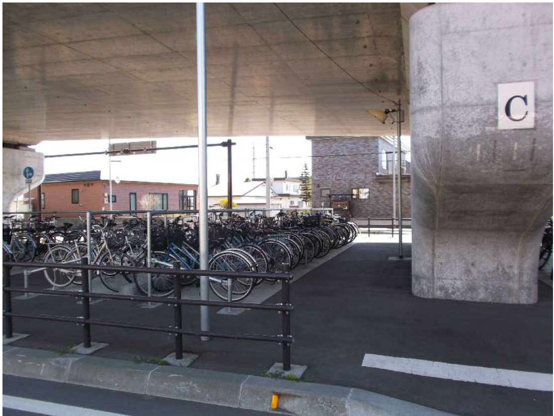
恵庭駅西口高架下自転車等駐車場Cブロック
