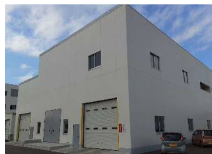
汚泥乾燥施設
