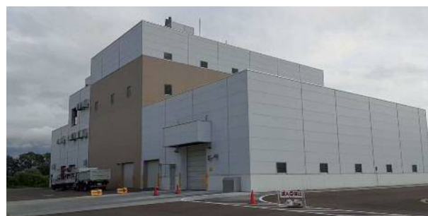
恵庭市焼却施設（ごみ焼却施設）
